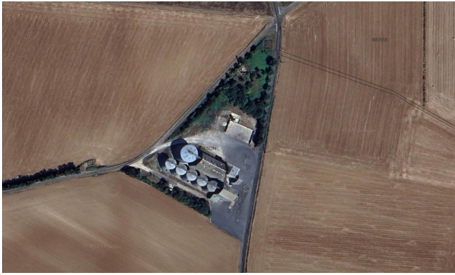
Entreprise CAVAC, RD61 à Tusson
