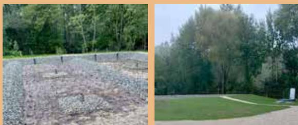
En septembre 2022, le groupement d'entreprise SOGEA / FOURNIÉ a réalisé la réhabilitation de la station d'épuration de Cellefrouin durant 12 semaines pour un montant total de travaux de 94 901 € HT. Le Bourg de Cellefrouin dispose d'une station d'épuration flambant neuve à filtres plantés de roseaux de 120 EH (Equivalent Habitant).
